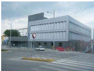
El edificio integral de la Seguridad Social, una obra ambiciosa cuya parte exterior quedará finalizada, según De la Encina, antes de que finalice abril. · Autor: J.R.
