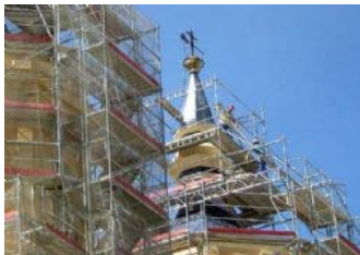
Unos obreros inician el desmontaje del andamio en una torre. · Autor: M. Fraile
