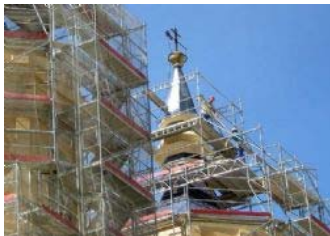
Unos obreros inician el desmontaje del andamio en una torre. · Autor: M. Fraile
