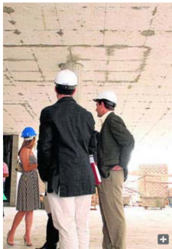
Imagen del interior del edificio cuando estaba aún sin terminar.
