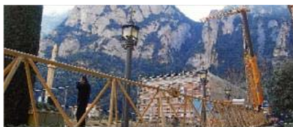
Trabajos de montaje, ayer por la mañana, de la grúa que se utilizará para remodelar el tejado del hotel Abat Cisneros
