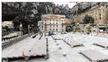
A los dos niveles inferiores ya se instalan las placas de acabado (izquierda). Situación del nivel superior (derecha) marta pich
