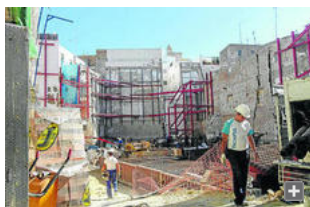
Obreros trabajan en la edificación de Osorio que da a la calle San Juan.
