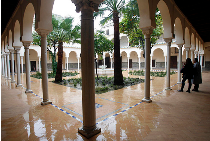
La primera fase de la rehabilitación recuperó espacios como el claustro del antiguo convento. / Javier Cuesta
