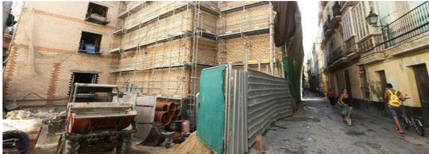
Estado de la estructura del nuevo edificio | A. V.
