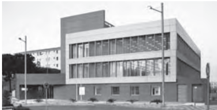
Nueva sede para la Tesorería de la Seguridad Social en Algeciras.
