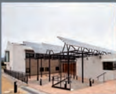
Suberoteca Alcalá de los Gazules
