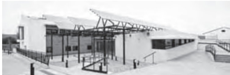
Suberoteca de Alcalá de los Gazules.
