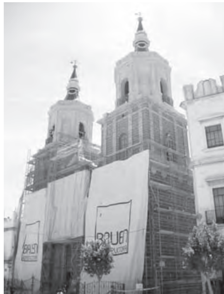
Iglesia Mayor de San Fernando durante los trabajos de restauración.
