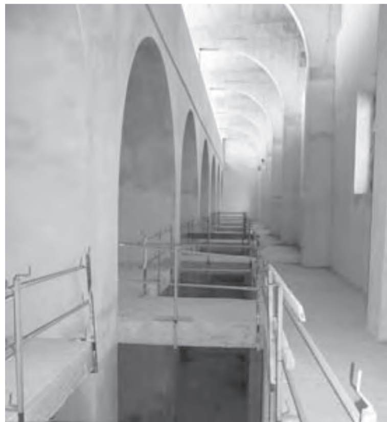
Interior del futuro Centro de Arte Contemporáneo de Cádiz.
