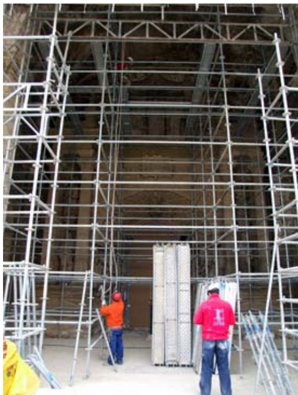
El pórtico mayor envuelto en andamios
