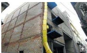
Estado actual de las obras en el Teatro Estable de Titeres.
