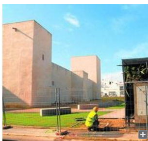
Un operario trabajando en el módulo anexo del Castillo de San Romualdo, en una fotografía de enero.
