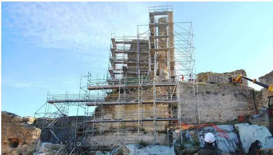
La imponente torre del Homenaje quedará salvada tras la unión de sus muros con materiales originales - A.M.
