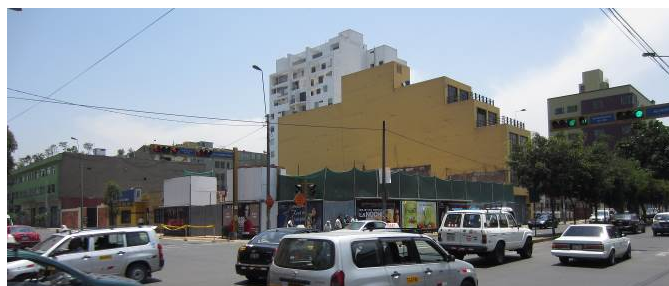
Vista del solar al iniciarse las obras.
