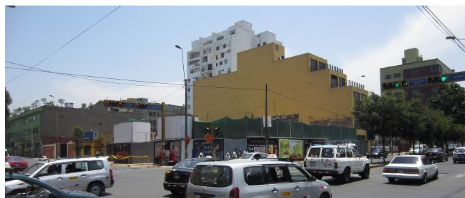
Vista del solar al iniciarse las obras.
